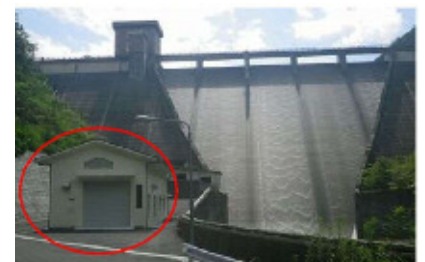
(大島ダム発電所)
