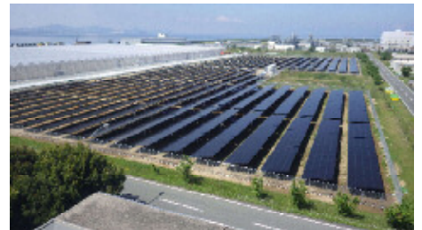
(豊川浄化センター)
