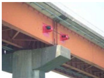
(落橋防止対策)
