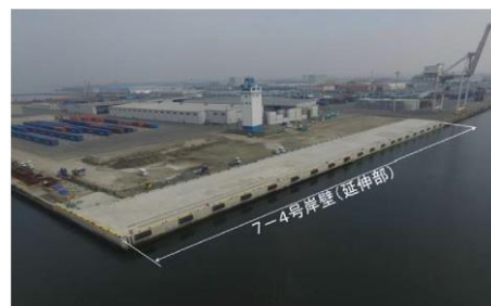
（耐震岸壁整備の状況）
