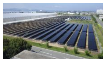
（豊川浄化センター）
