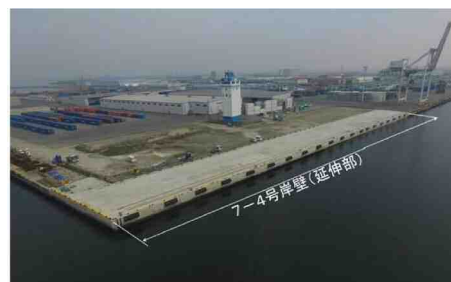
(耐震岸壁整備の状況)
