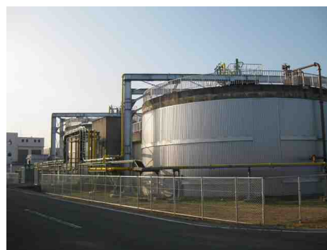
(豊川浄化センター：PFIで再稼働したメタン発酵施設)
