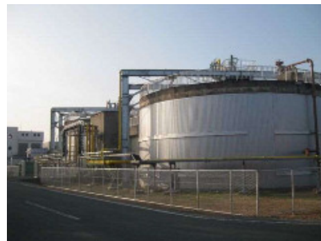
(豊川浄化センター：PFIで再稼働したメタン発酵施設)
