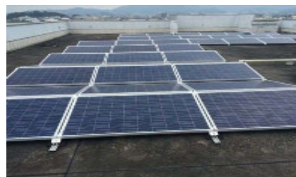
(屋根貸し太陽光発電・水産試験場)
