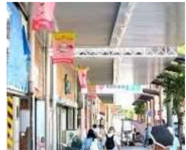
(アーケードの改修)
